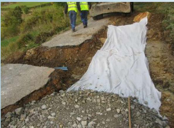
Suivant les conseils du maître-d'œuvre, d'importants travaux de drainage et de renforcement ont été effectués sur les portions de route très dégradées espérant ainsi diminuer la fréquence des travaux d'entretien.
